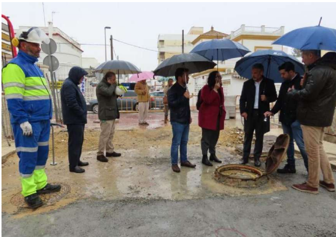
Las obras de mejora del saneamiento en la calle Écija afrontan su fase final con la culminación de la colocación de la solería que permitirá restituir el firme tras la instalación de un nuevo colector.
