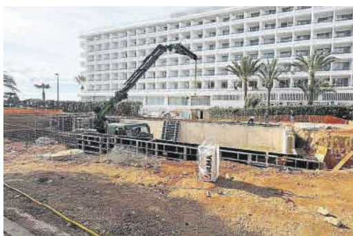
Obras en el tanque de tormentas, este viernes.
