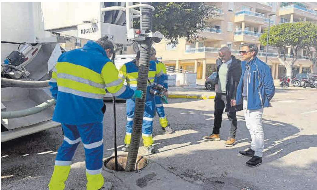
Unos operarios realizan labores de limpieza en la calle Mediterrània.
