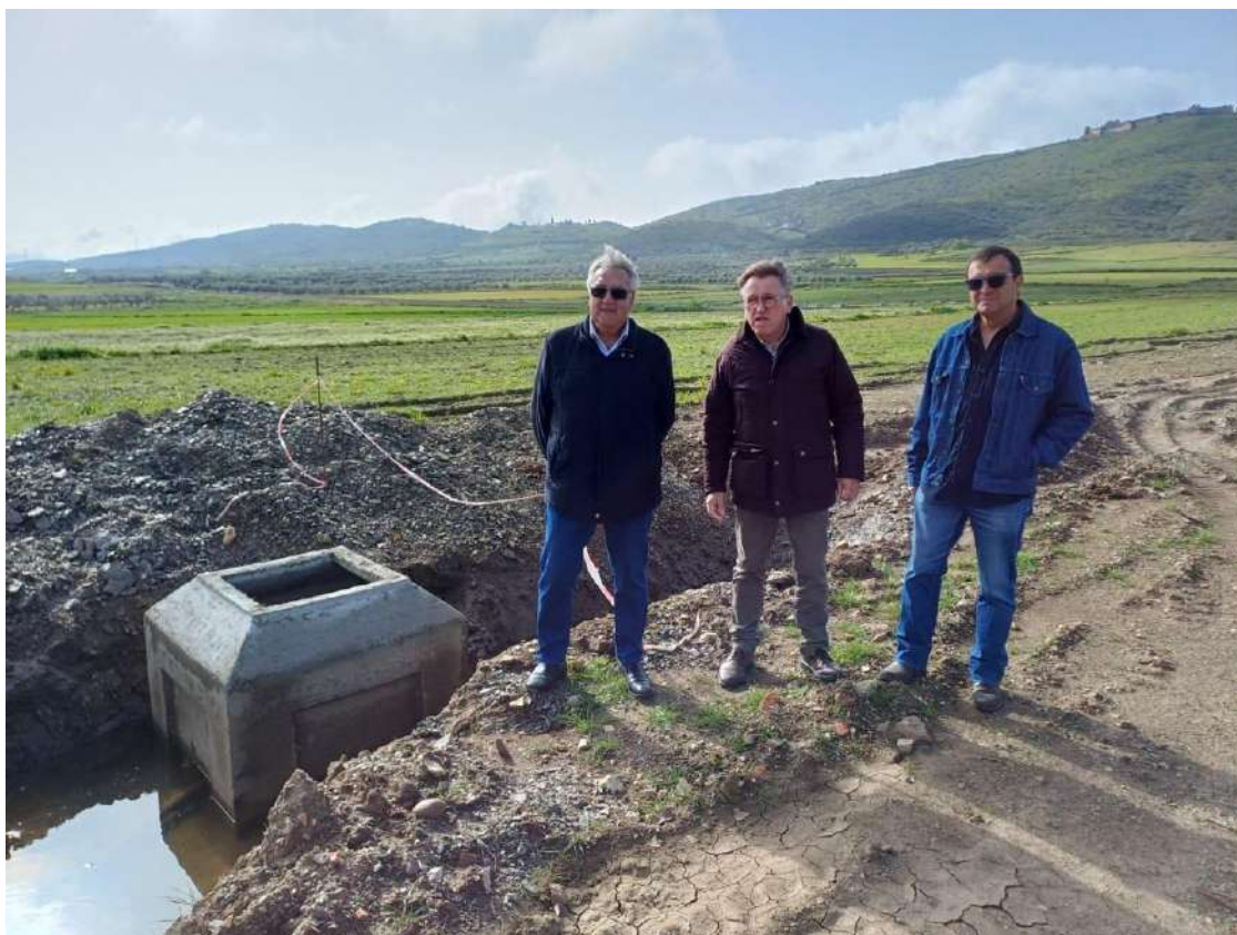
Visita a las obras hídricas que aseguran el abastecimiento al yacimiento de Regina.
