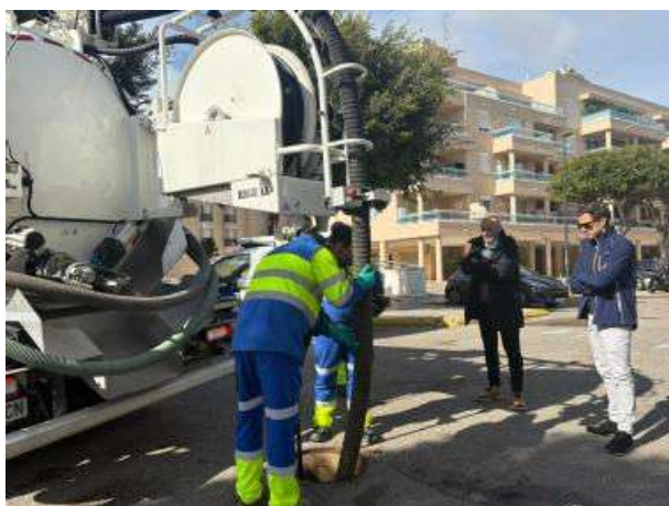
Técnicos del Ayuntamiento limpian los imbornales ante la llegada de la nueva borrasca | Foto: R.I.
