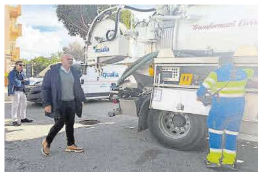
El concejal Grivé supervisa los trabajos.
